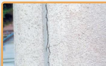
目地部のシーリング材劣化とひび割れ
