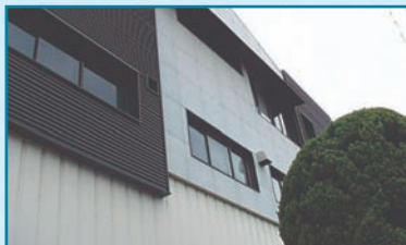
▼コンクリート・モルタル
