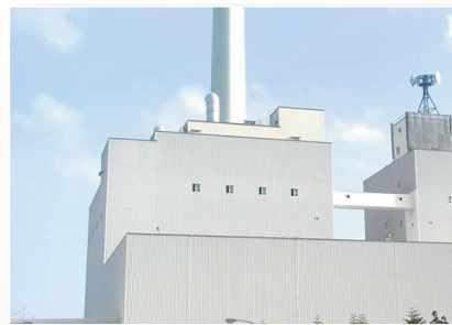
外壁塗膜防水仕上(アトロンエラストマー)
